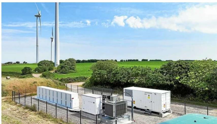
**Figure 28 :** Installation hybride batterie – éolienne dans le Finistère (Lionel Le Saux / Le Télégramme).
