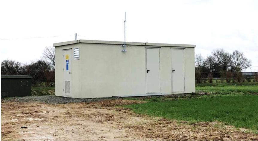
**Figure 26 :** Batterie stationnaire de 1,25 MW installée dans la Sarthe (Ouest-France, 2023).
